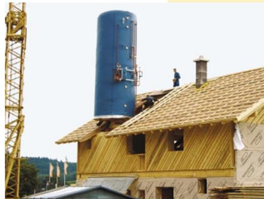
Ein Wärmespeicher im Gebäude für überschüssige Energie aus Solarkollektoren und Wärme-Kraft-Anlagen ist ein wichtiger Schritt bei der Umstellung auf erneuerbare Energien. Diese ausgereifte Technologie sollte bei jedem Neubau eingesetzt werden. (Bild: Speicher von Jenni Energietechnik)
